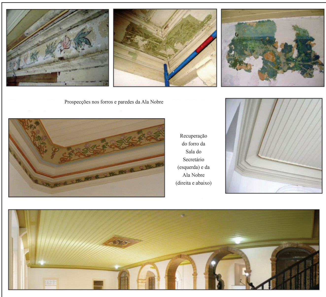
Figura 13. Prospecções das pinturas e recuperação de forros da Ala Nobre da Faculdade de Medicina da Bahia.
