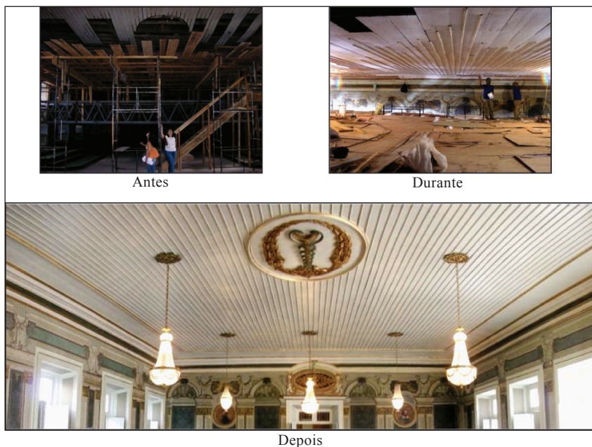
Figura 8. Recuperação do forro do Salão Nobre da Faculdade de Medicina da Bahia.
