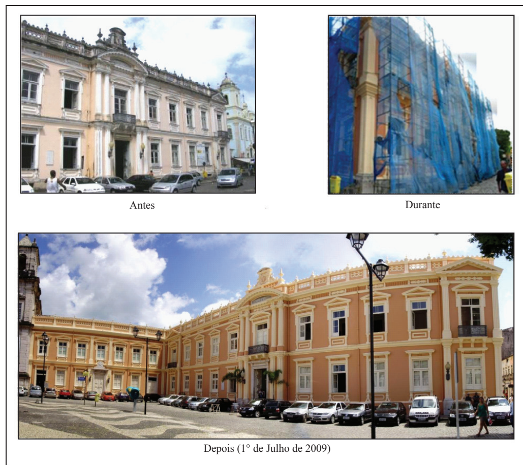
Figura 14. Recuperação da fachada principal da Faculdade de Medicina da Bahia.
