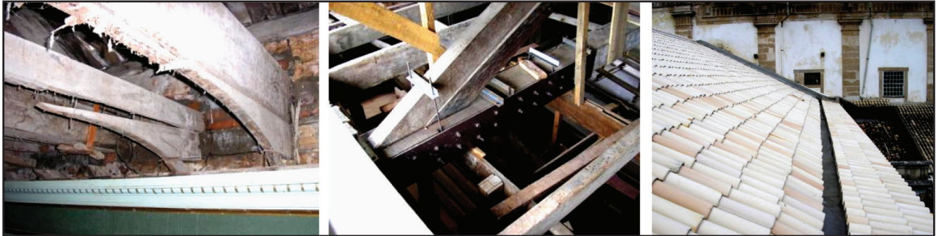
Figura 7. Recuperação da cobertura do Salão Nobre da Faculdade de Medicina da Bahia.
