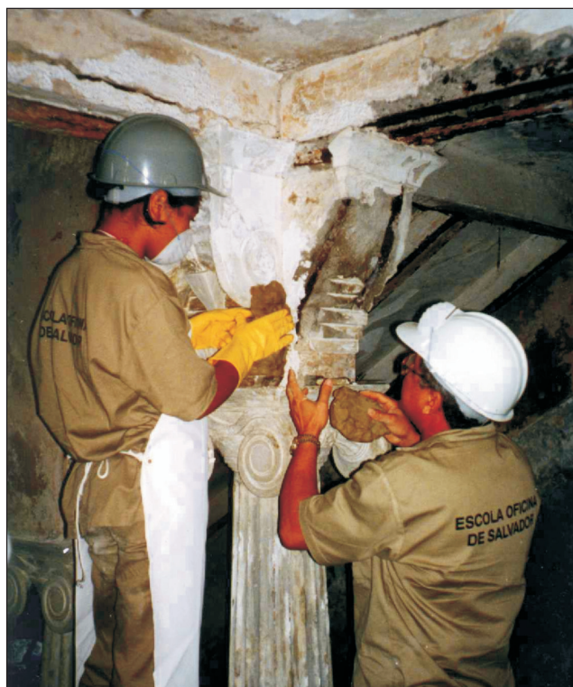
Figura 19. Trabalho do Mestre e da Aprendiz, na retirada dos moldes dos capitéis, antes da restauração dos elementos decorativos.
