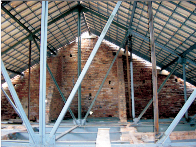
Figura 11. Vista geral da estrutura da cobertura, após a restauração e execução do telhado.
