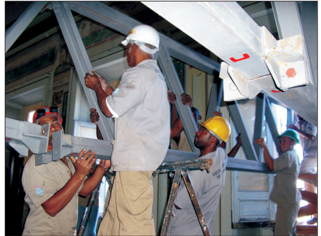
Figura 34. Construção da estrutura metálica para escoramento da cobertura do Salão Nobre, constituída de treliças metálicas apoiadas nos vãos das janelas.
