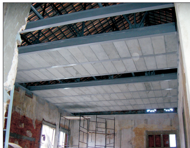
Figura 10. Montagem do forro com placas de argamassa armada, apoiadas em vigamento metálico.
