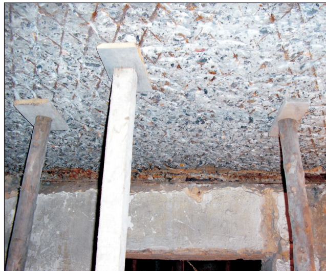
Figura 7. Laje em tratamento: remoção do concreto superficial, mostrando os vestígios da tela deployé .
