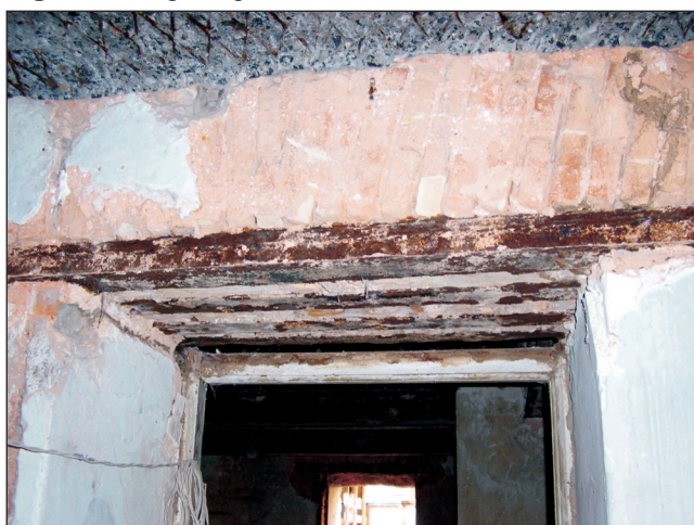
Figura 9. Verga de porta constituída de trilhos, no subsolo.
