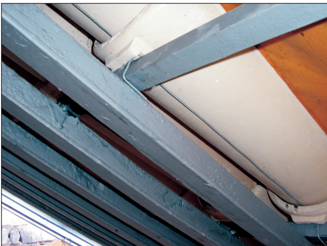
Figura 12. Detalhe do acréscimo de ripa metálica na estrutura da cobertura e do grampeamento das telhas com arame galvanizado.
