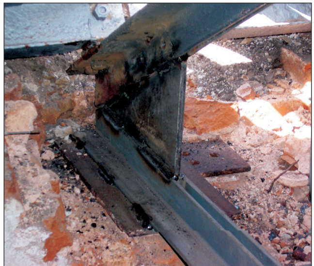
Figura 13. Detalhe do apoio da tesoura sobre parede, após a intervenção e remoção das partes oxidadas.
